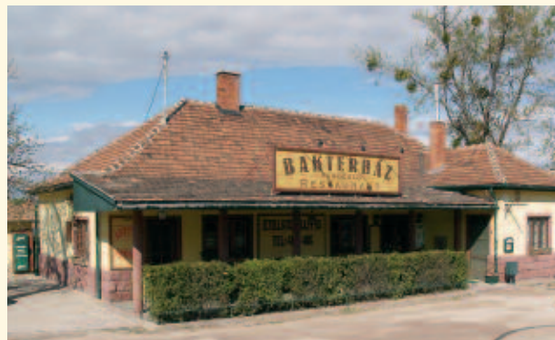
4. A régi Kisállomás épületében ma étterem működik
